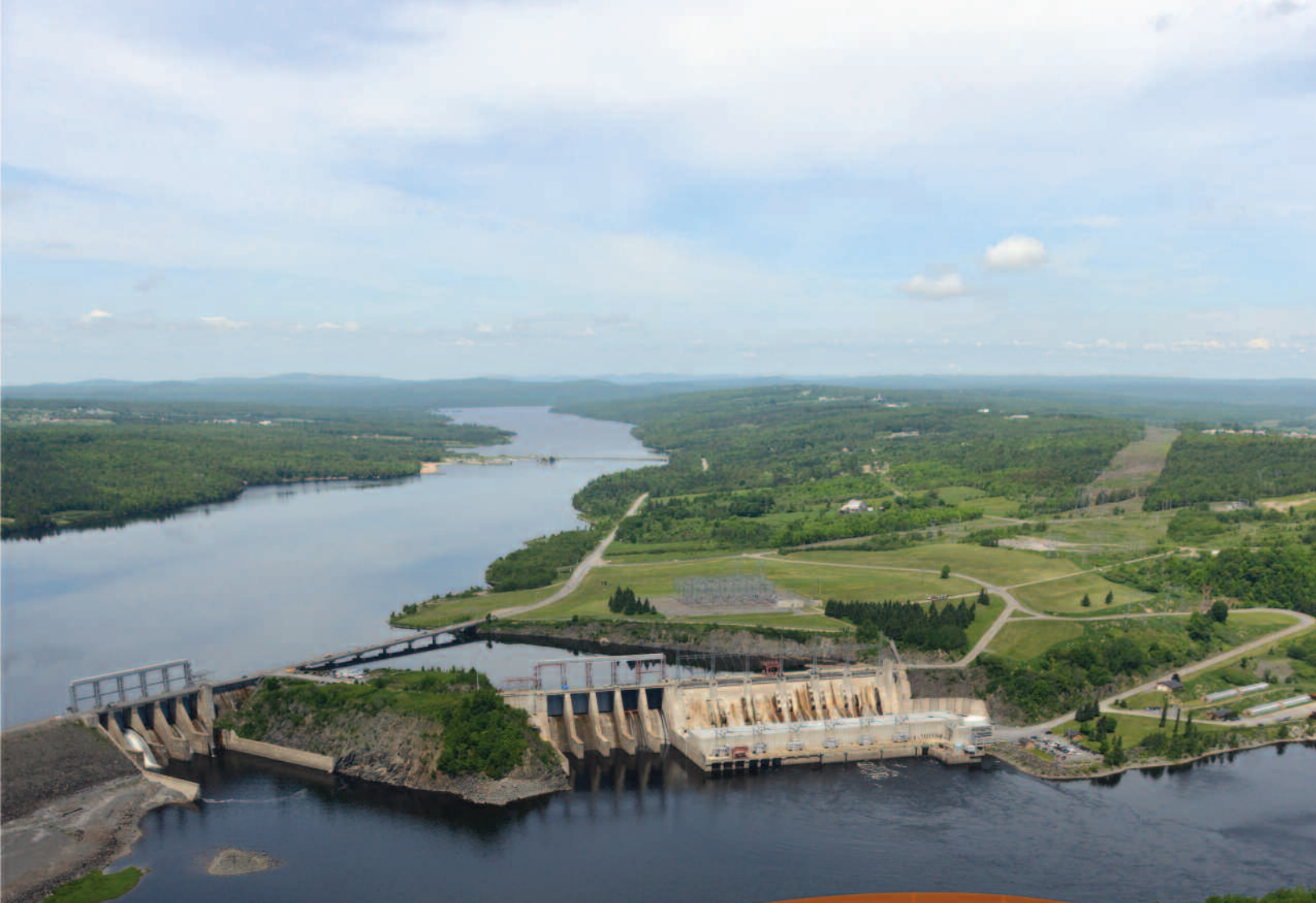
Centrale de Mactaquac
