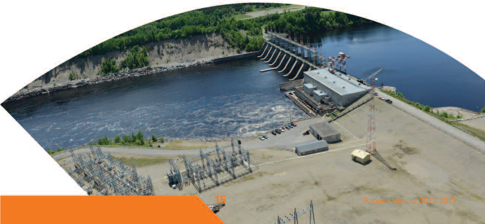
Centrale hydroélectrique de Beechwood
