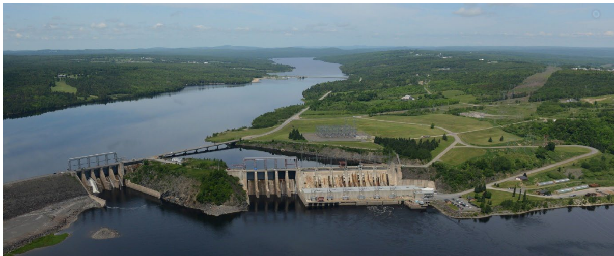
Figure 8.2 : Centrale hydroélectrique de Mactaquac
